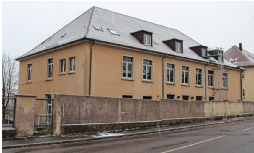
Auch in der Friedhofstraße wird es Veränderungen geben. Dieses Gebäude wird abgerissen und ein neues entsteht. Das Haus rechts daneben bleibt erhalten.
